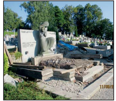
V průběhu prací
