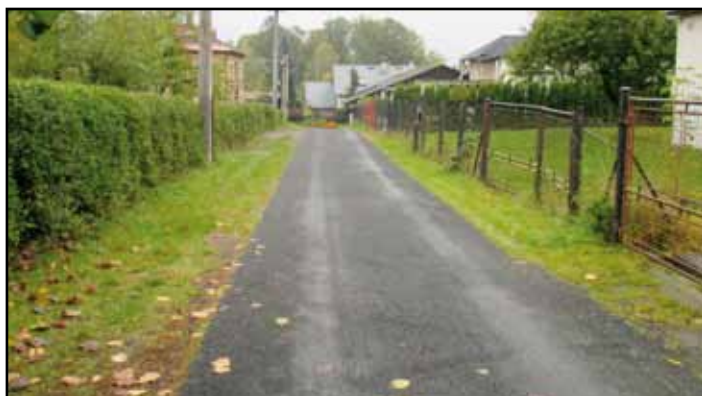
Oprava nátěrem ulic Tylova, Vaverkova - Příčnice, serpentýny na Příčnici Kč 62 920,-
