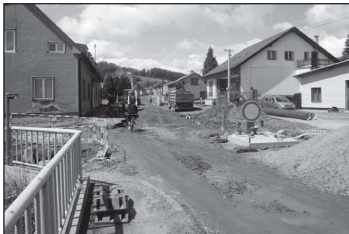
Výstavba kanalizace v horní části Zbečníka
