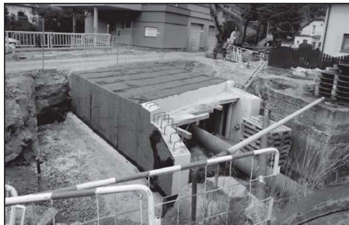
Rekonstrukce mostu u bývalé hasičské zbrojnice.
